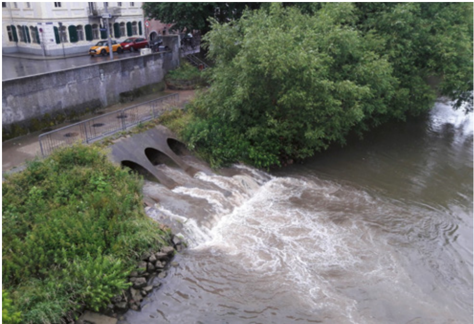
Abb. 2 Regenüberlauf Weißgerbergraben während eines Starkregenereignisses; Foto: Joachim Buck
