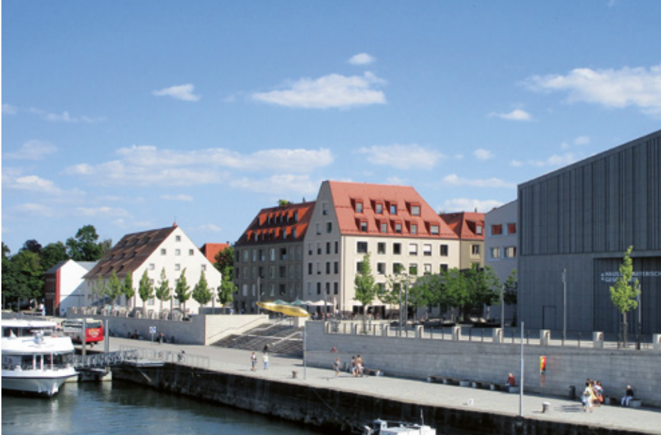
Abb. 05 Hochwasserschutz Regensburg, Abschnitt P: Donaulände/Marc-Aurel-Ufer; Foto: Joachim Buck
