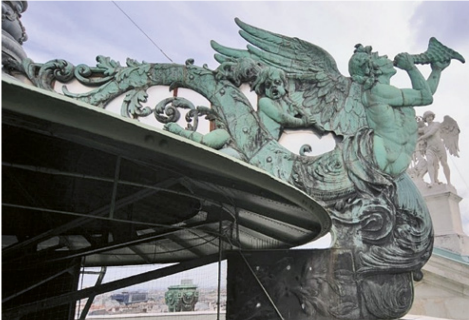
Abb. 1 Blasengel am Dach des Burgtheaters; © Friedrich Idam, Hallstatt
