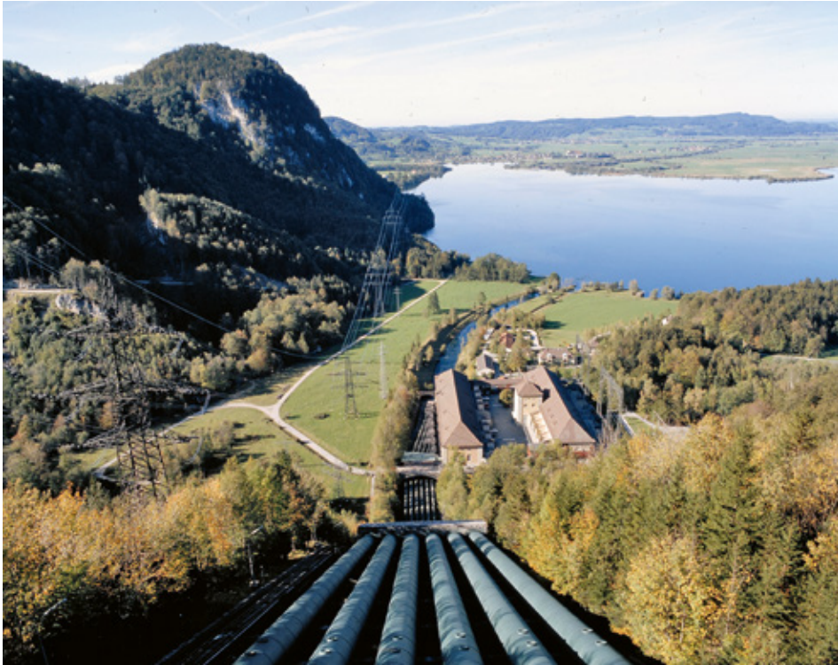
Abbildung 3 Walchenseekraftwerk, Hochdruck-Speicherkraftwerk zur Ausnutzung der Gefällestufe zwischen Walchen- und Kochelsee, 2009, Bayerisches Landesamt für Denkmalpflege; Foto: Eberhard Lantz
